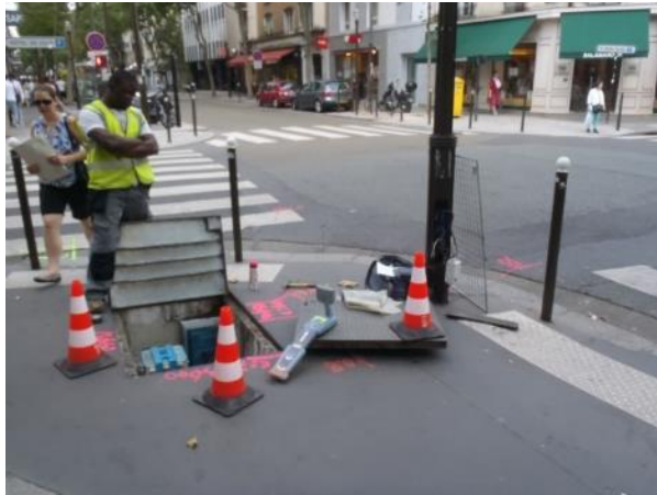
Figure 5 : Photo de chantier avec matériel de détection électromagnétique
